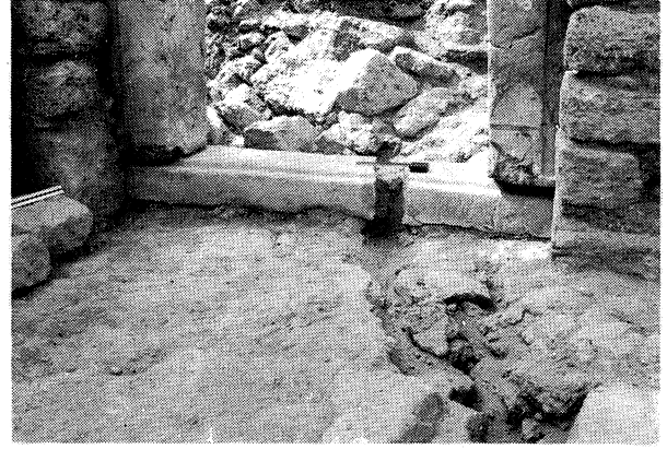
Şekil 6. Bizans dönemine ait üç kuleli kalenin kapı eşiğini kesen sağ yönlü doğrultu atımlı fay. Fay zeminde de görülmektedir (Tusan Motel'in güneydoğusu).
